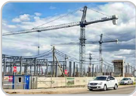
Балаково Строительство Регионального ЦОД
