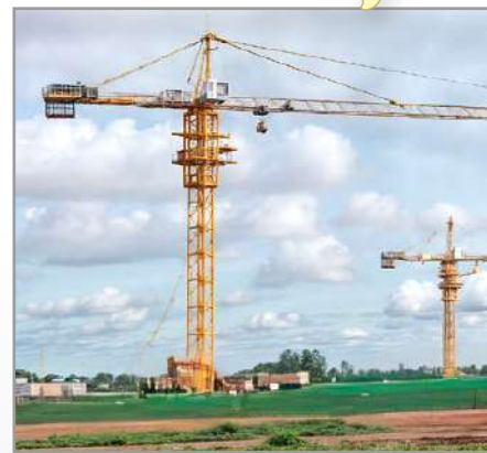
Административный город в Бенине (C6010). Общая площадь строительства составляет 76000 м².
