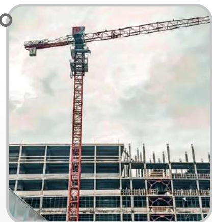
Нижнекамск Строительство административно-бытового комплекса Сибур
