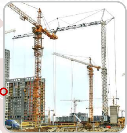
Екатеринбург Строительство жилых домов мкр. Академический
