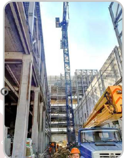
Нижнекамск Строительство объекта Татнефти
