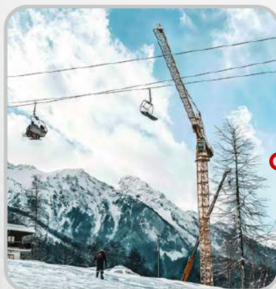
Сочи, Красная поляна Строительство жилого комплекса
