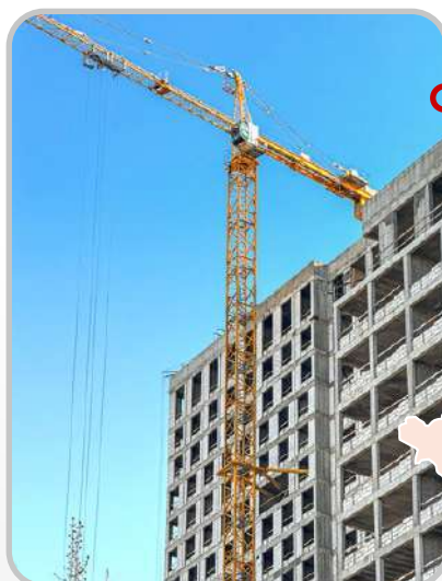
Москва Строительство ЖК «Страна озерная»
