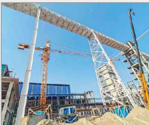
Коксохимический завод Detian Coking, Индонезия (C6010).
