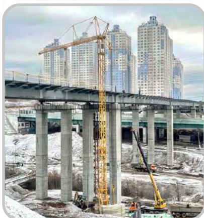
Пермь Строительство автомобильной дороги, мост через р. Ива
